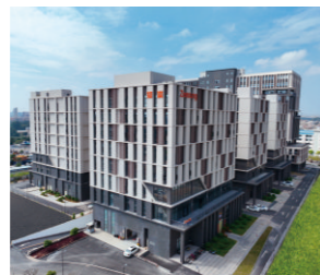
园区一期实景图
