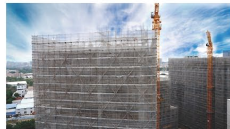
园区二期建设实景图
